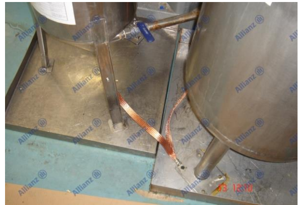
Resim 10 Bonding (eş potansiyel bağlantısı) yapılmış tanklar)
