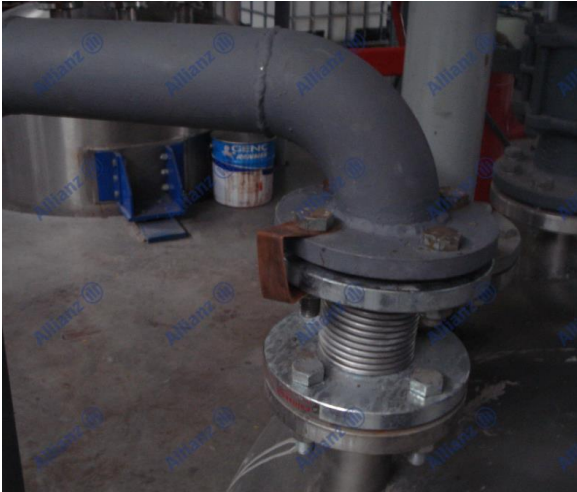
Resim 8 Eş potansiyel bağlantısı
