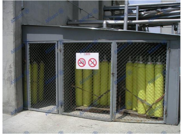
Resim 21 Basıncı tüp depolaması
