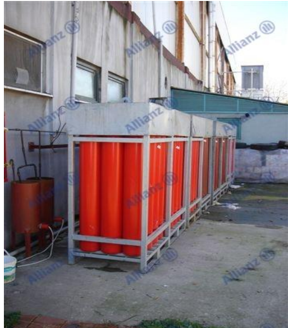
Resim 22 Basıncı tüp depolaması
