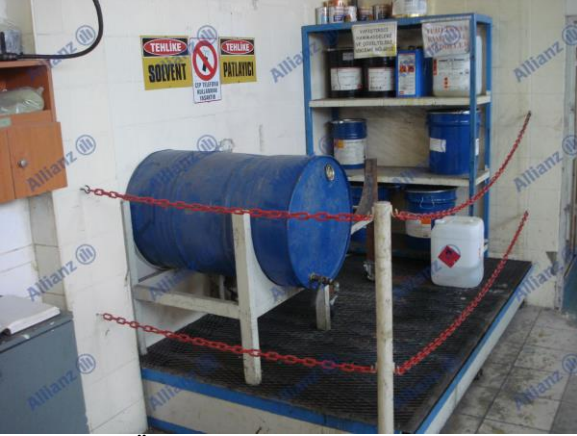
Resim 19 Örnek bir depolama (taşmaya karşı delikli tekne)
