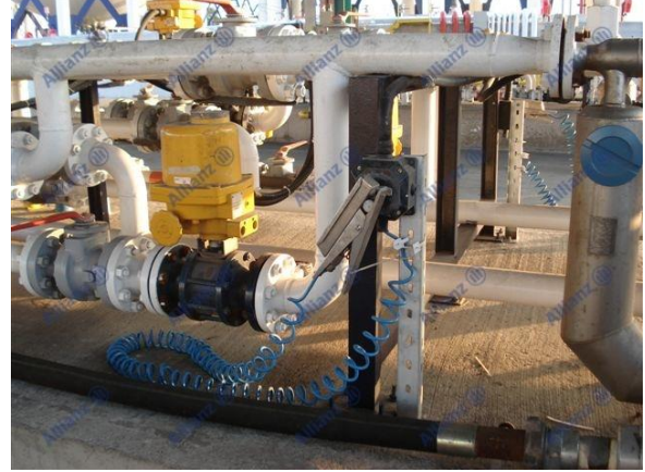
Resim 9 Dolum sırasında yapılan seyyar topraklama
