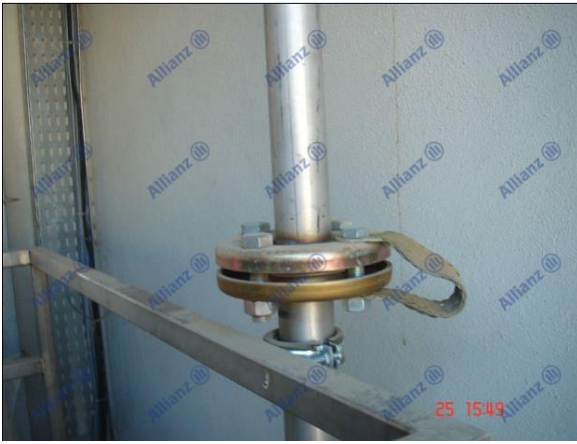
Resim 7 Eş potansiyel bağlantısı
