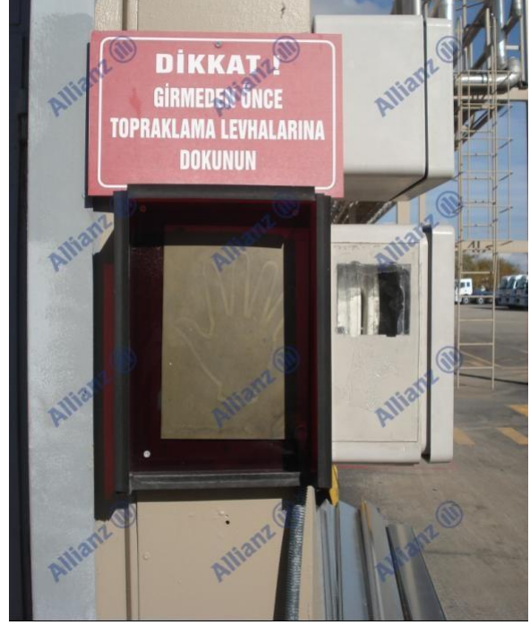
Resim 13 Topraklama levhası
